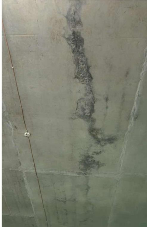
Фото Ф-19-20. III этап строительства. Локальные следы протечек по плите покрытия.
