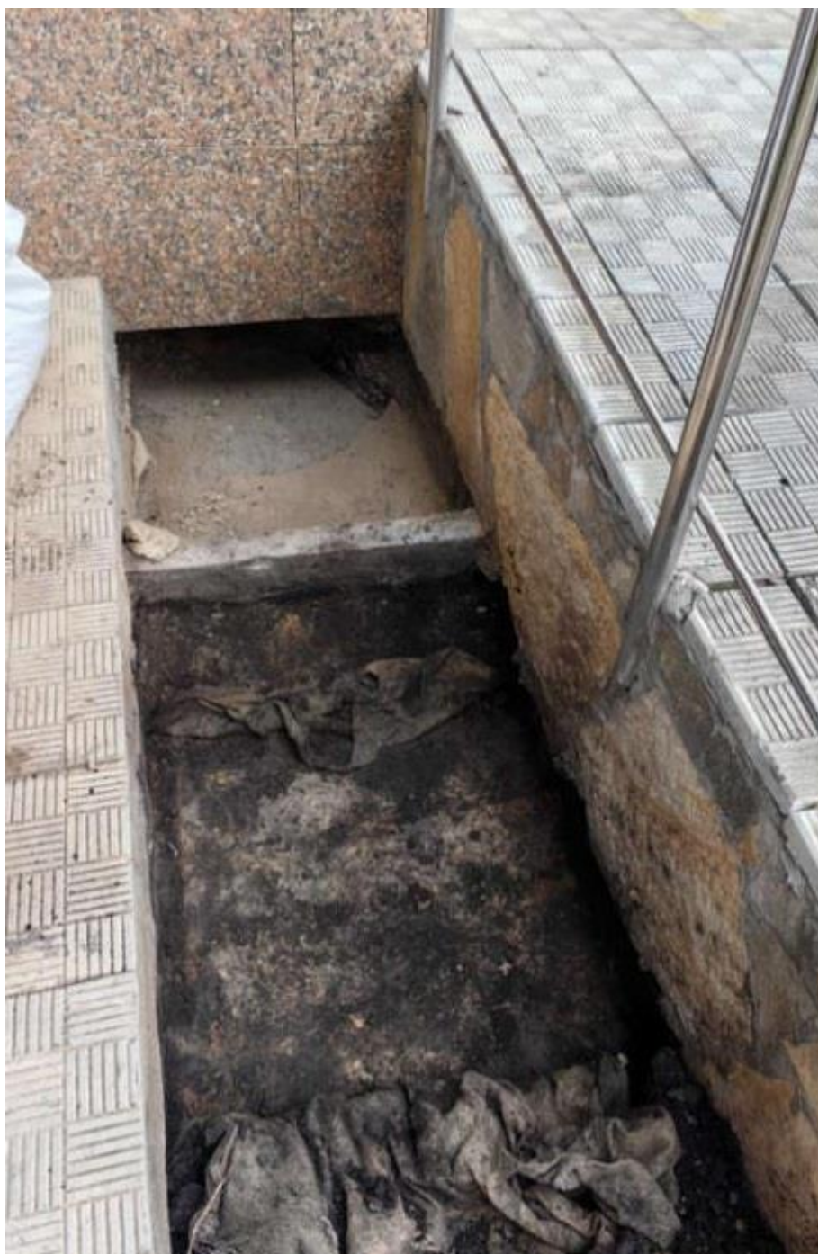
Общий вид Шурфа Ш-2
