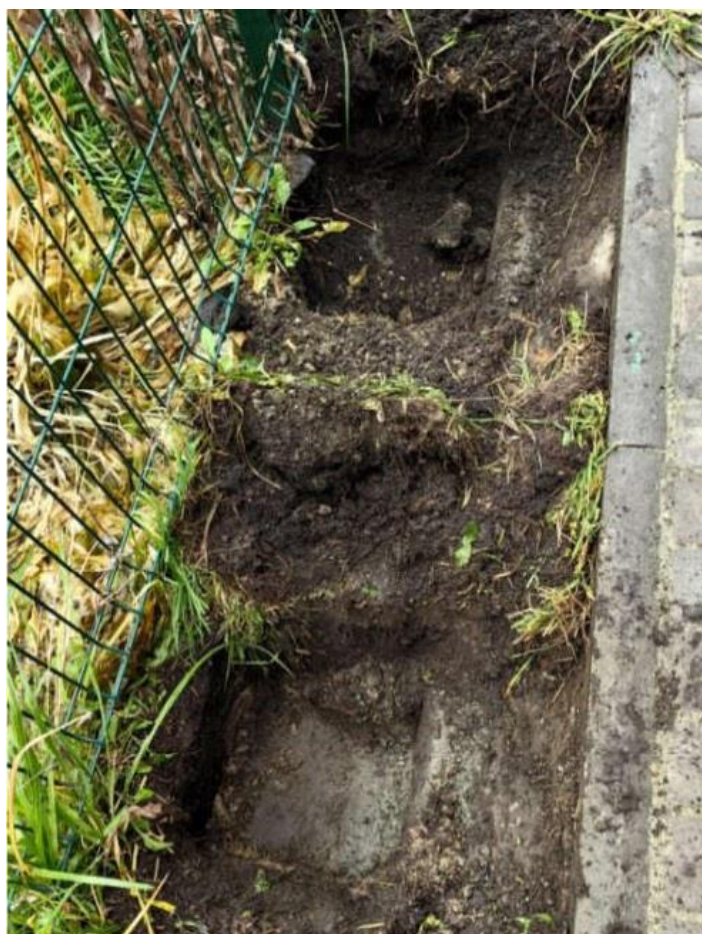
Общий вид Шурфа Ш-3
