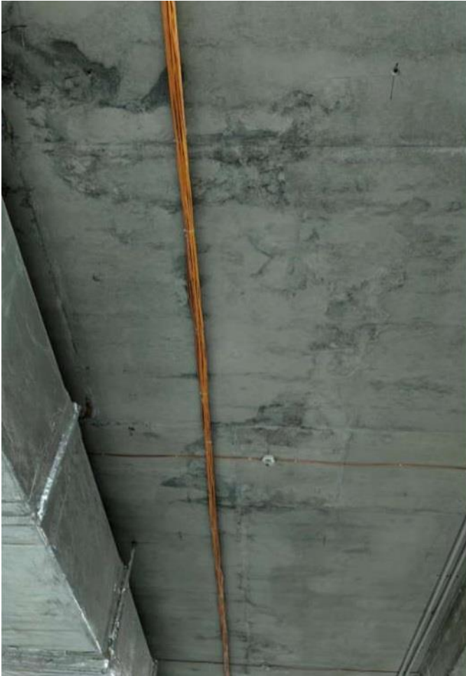
Фото Ф-19-20. III этап строительства. Локальные следы протечек по плите покрытия.
