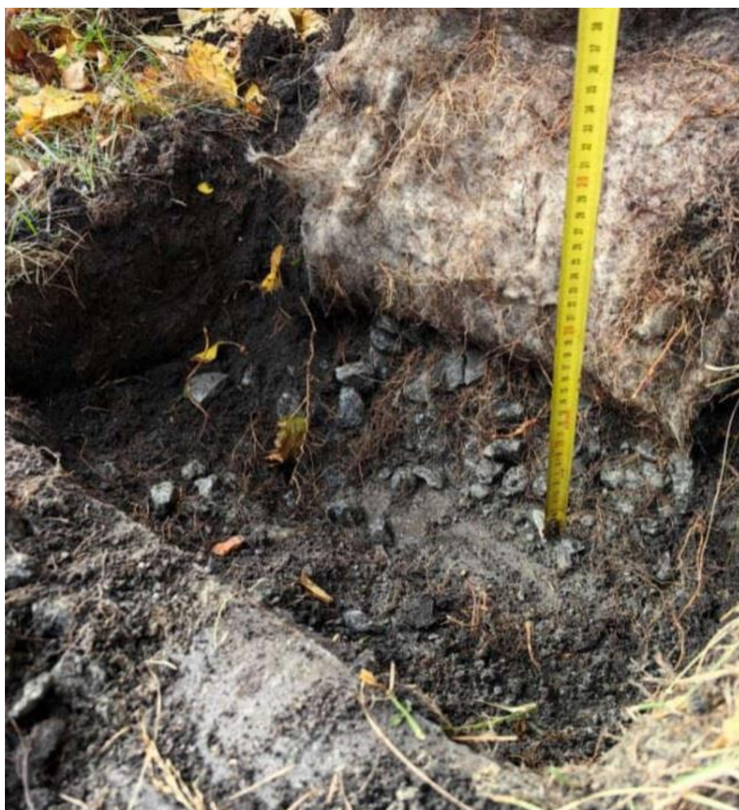
Общий вид Шурфа Ш-5.
